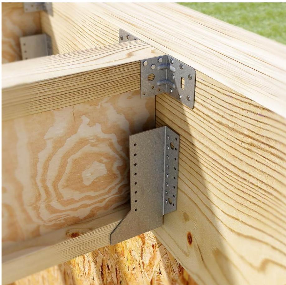
**Méthode :** Le sabot doit reprendre la membrure basse et les deux équerrés la membrure haute.
